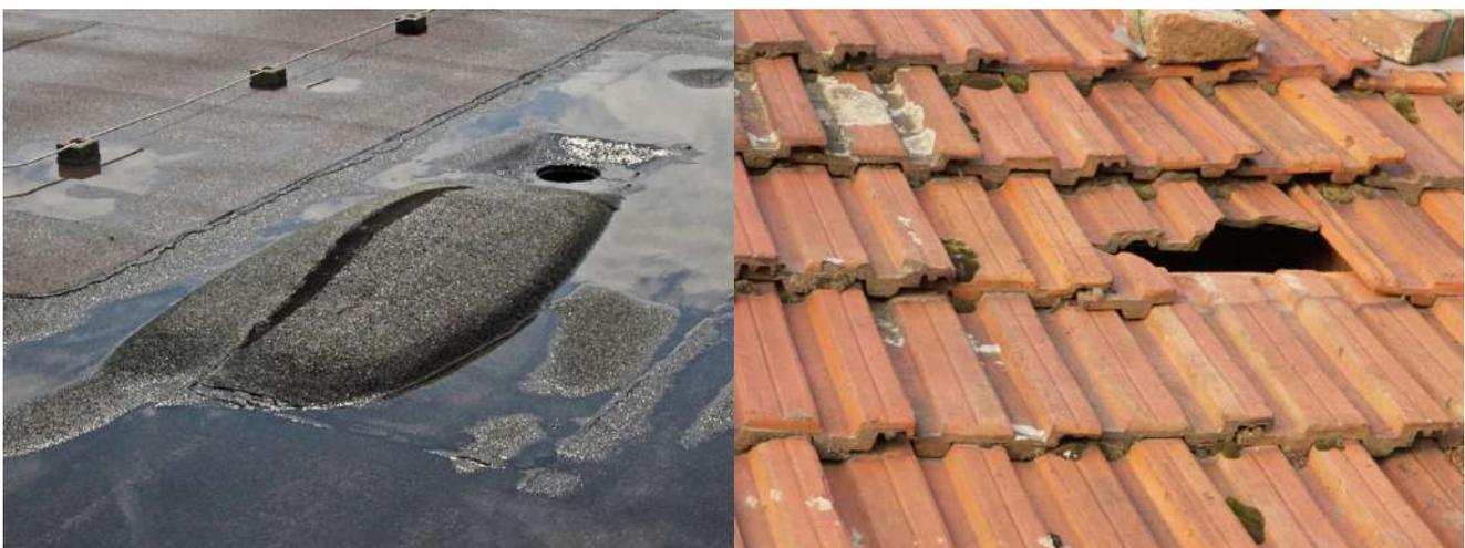
Figure 3 Dommages typiques sur les toits ([www.bauder.at](http://www.bauder.at) / [www.hausjournal.at](http://www.hausjournal.at))
