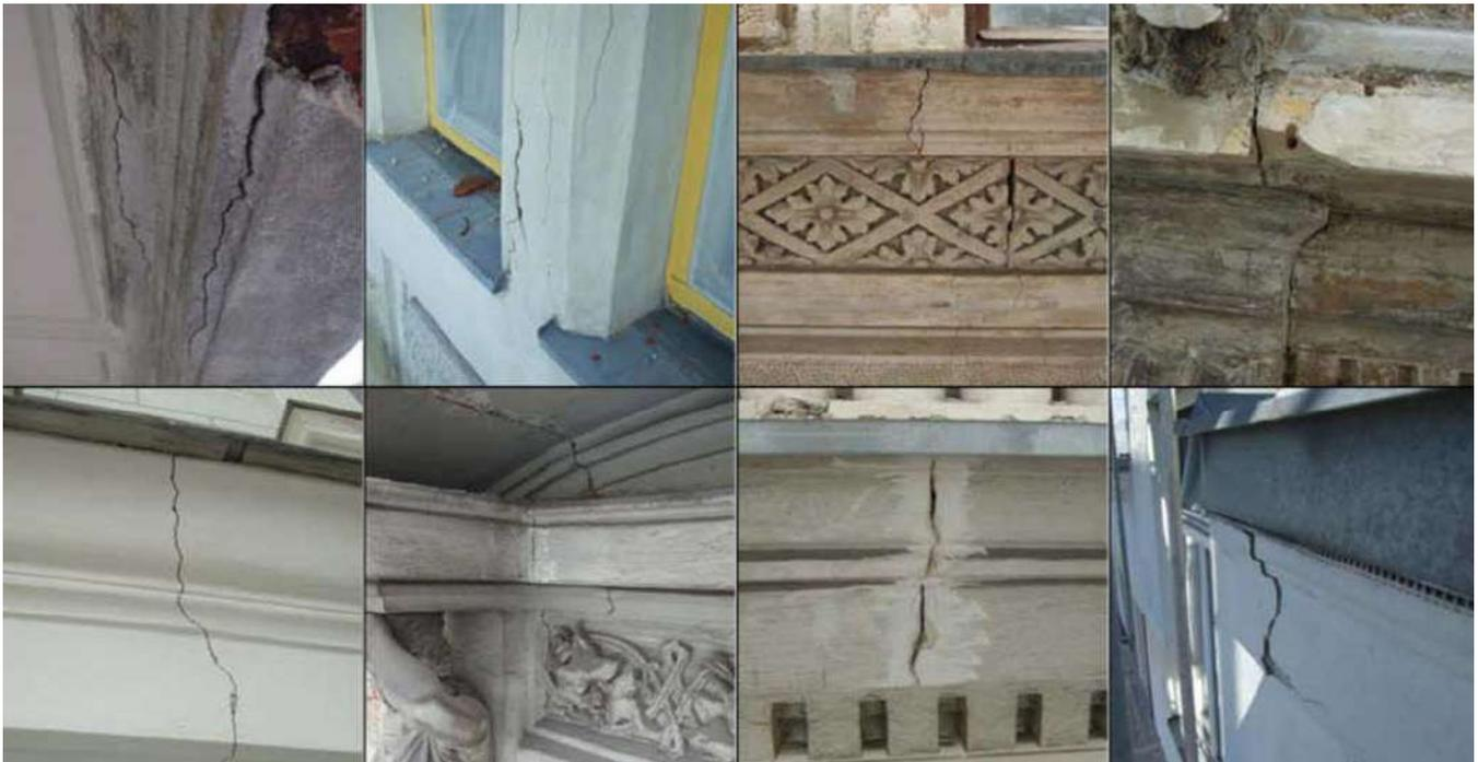
Figure 2 Dommages typiques sur façade (<https://www.zukunft-bau.at/bauschadensberichte>)
