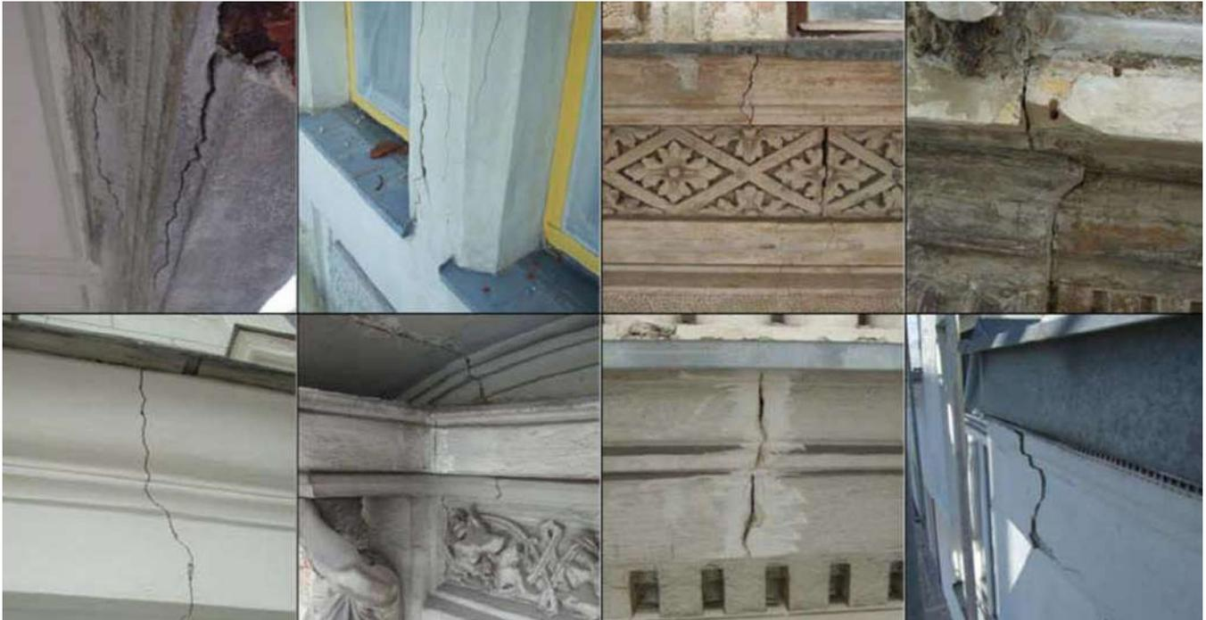
Abbildung 2: Typische Schäden an Fassaden (<https://www.zukunft-bau.at/bauschadensberichte>)
