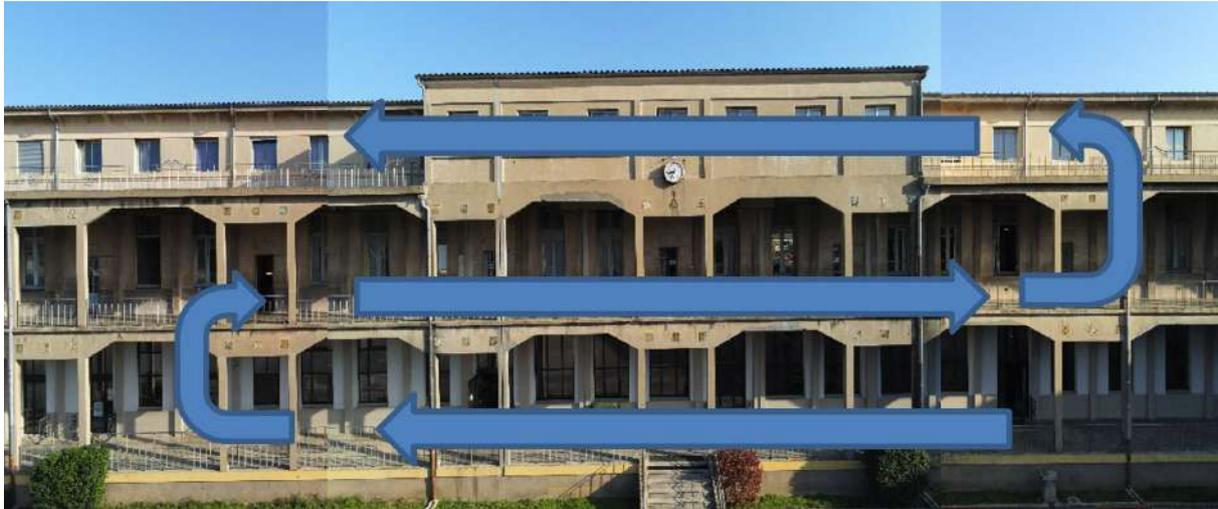
Abbildung 3-8 Pfad für die Fassadenfotogrammmessung
