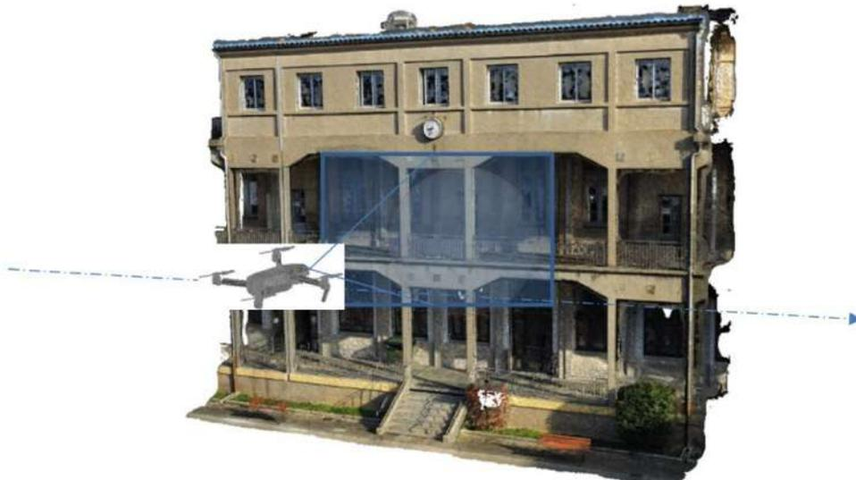
Abbildung 3-7 Bilder eines Gebäudes für die Fassaden-photogrammetrie
