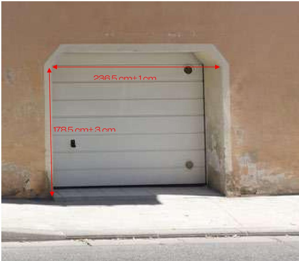
Abbildung 5-21 Abmessungen an einer Tür gemessen
