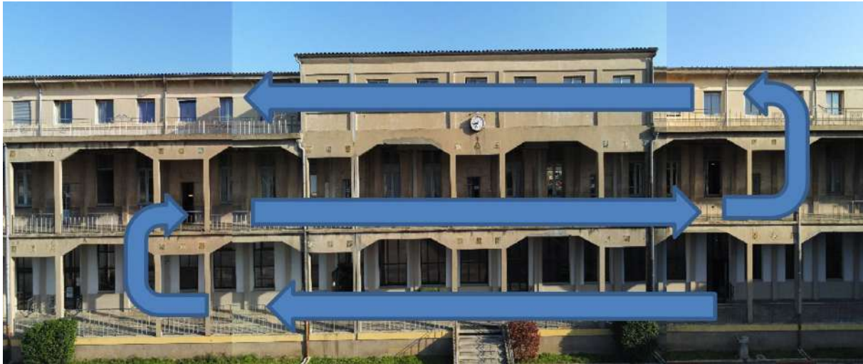
Figura 3-10 recorrido para fotogrametría de fachada
