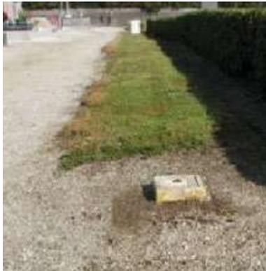
*Figure 4-26 repère géodésique en béton et en bronze en France (IGN)*
