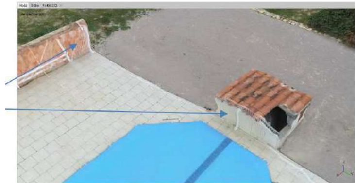
Figure G-12 Le modèle tuilé se positionne par défaut sur la clôture métallique de la piscine
