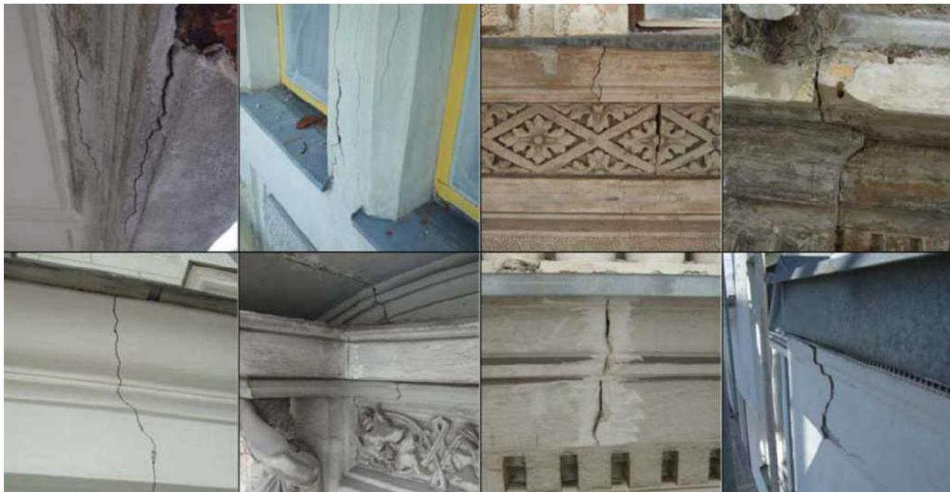
Figure 2 Dommages typiques sur façade (<https://www.zukunft-bau.at/bauschadensberichte>)
